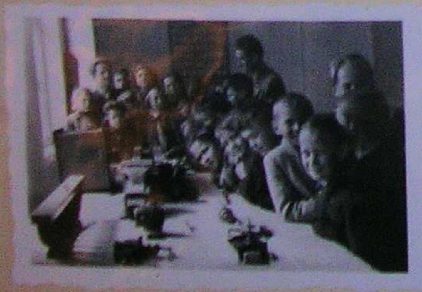
Prace przy umieszczeniu wyprawy.
